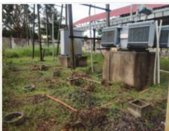
Grounding & Earthing of Transformer ट्रांसफार्मर की ग्राउंडिंग और अर्थिंग
