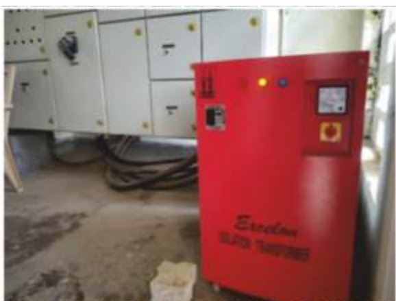
Isolation Transformer at SCIF एससीआईएफ में आइसोलेशन ट्रांसफार्मर
